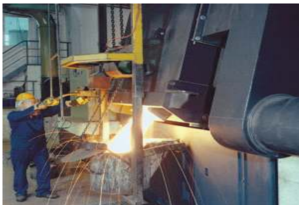
Электроплавильная печь в литейном цехе фирмы Альввайлер
