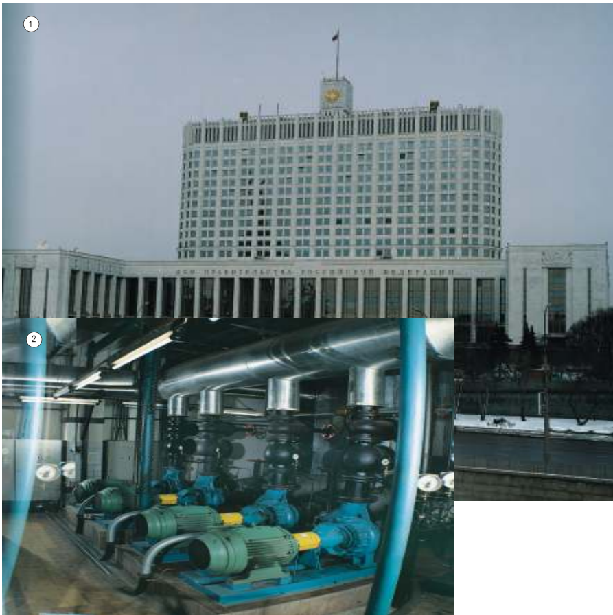
1 2 Центробежные насосы АЛЛЬВАЙЛЕР со спиральным корпусом серии NT в установках кондиционирования воздуха "Белого Дома" в Москве
