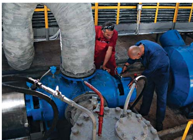
Пуско-наладка двухвинтовых насосов HOUTTUIN для разгрузки ж/д цистерн мазута и налива в танкер на нефтяном терминале, г. Севастополь.
