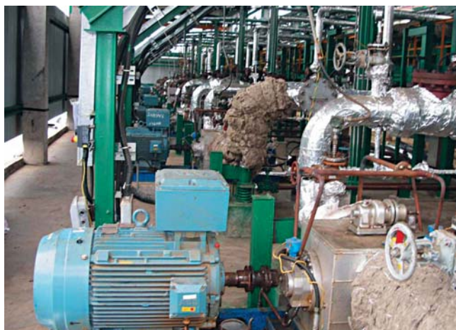
Монтаж-наладка двухвинтовых насосов HOUTTUIN на установке автоналива битумов и мазута, ЯНОС.
