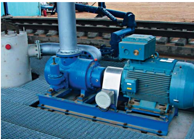
Двухвинтовые насосы HOUTTUIN серии 236 в Морском торговом порту «Усть-Луга» на ж/д эстакаде слива мазута.
