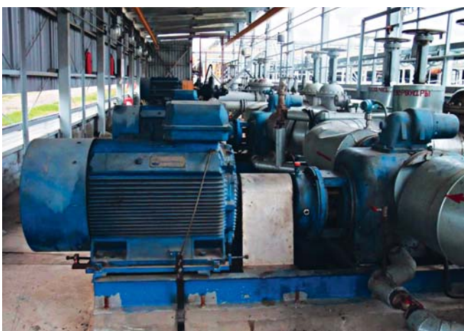
Двухвинтовые насосы HOUTTUIN серии 236 для налива мазута в танкер, терминал под г. Азов.
