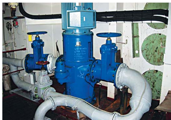
Вертикальный насос HOUTTUIN серии 231 для разгрузки нефтепродуктов на плавтерминале, г. Мурманск.
