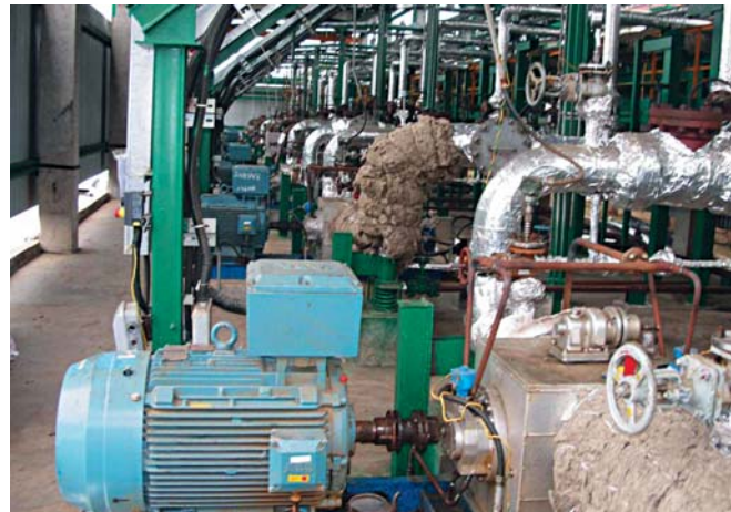
Монтаж-наладка двухвинтовых насосов HOUTTUIN на установке автоналива битумов и мазута, ЯНОС.
