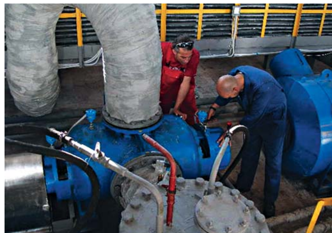
Пуско-наладка двухвинтовых насосов HOUTTUIN для разгрузки ж/д цистерн мазута и налива в танкер на нефтяном терминале, г. Севастополь.
