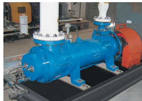
Фото 2. Трехвинтовой насос Imo в трубопроводной системе перекачки сырой нефти в Западной Канаде
