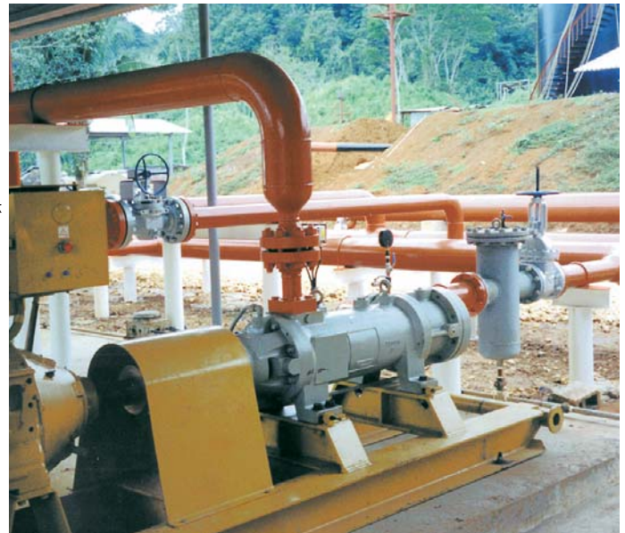
Насосы 8L- 400 с дизельным приводом, установленные на трубопроводе в Центральной Америке, перекачивают 14000 баррелей в сутки сырой нефти с вязкостью 2000 сСт под давлением 96 бар.
