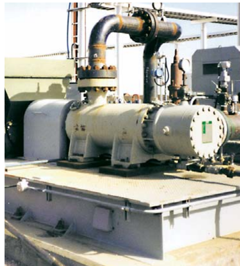
Насосы 8L- 400 с дизельным приводом, установленные на трубопроводе в Центральной Америке, перекачивают 14000 баррелей в сутки сырой нефти с вязкостью 2000 сСт под давлением 96 бар.
